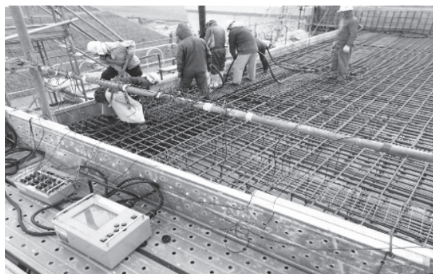
図-9 コンクリート打設状況
