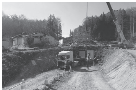
図-5 製品搬入状況
