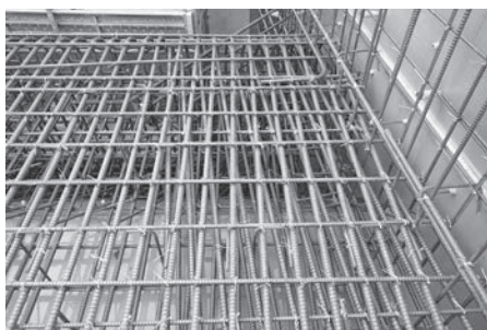
図-4(2) 端部配筋状況 (図-3 A部)
