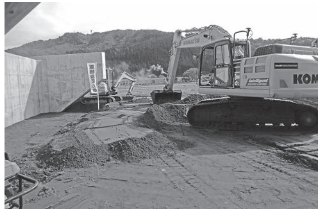
図-3 MCバックホウ敷均し
