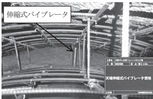
図-11 天端伸縮式バイブレータ
