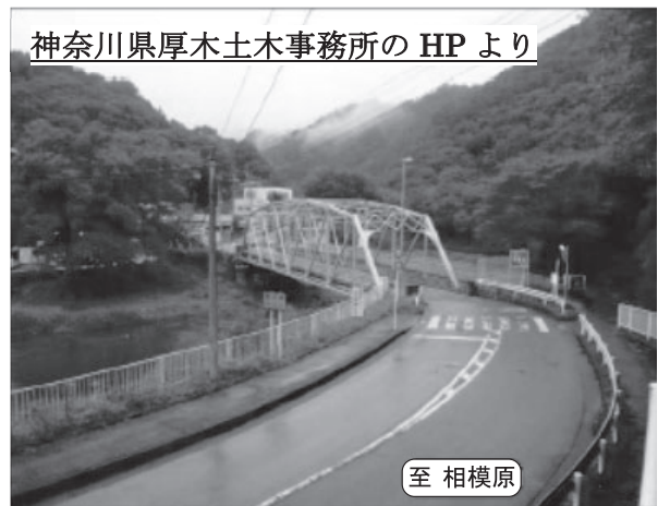
図-1 旧橋供用時
