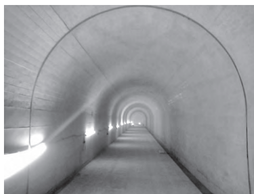
図-1 リムトンネル完成写真
