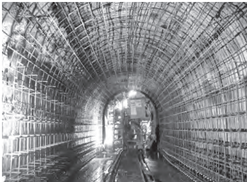
図-10 覆工の複鉄筋組立
