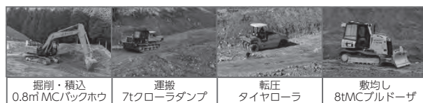
図-2 ICT建機による施工状況
