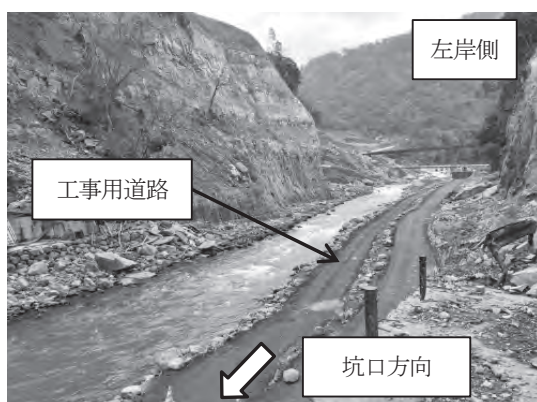
図-5 工事用道路
