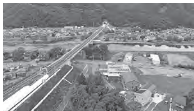
三陸沿岸道路（大槌IC付近）
