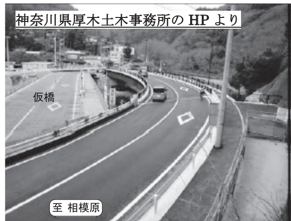
図-3 新橋供用状況
