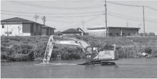
図-6 ICT建機による水中掘削
