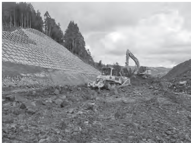
写真－４ リップドーザ掘削状況
