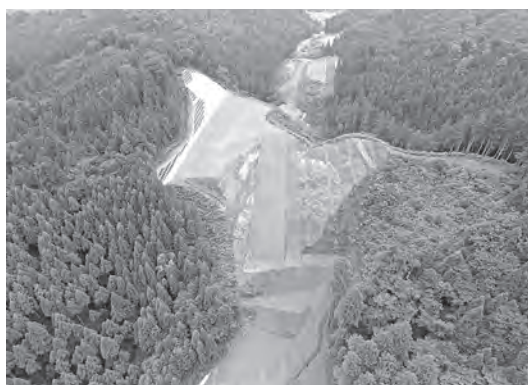
写真-2 2019年8月頃 本工事着工前
