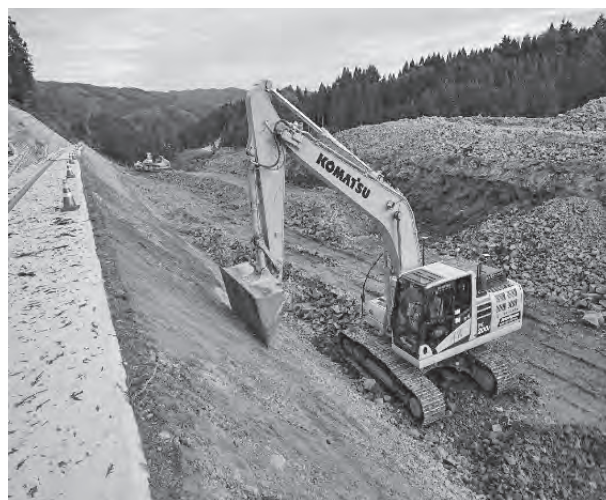
写真－５ 切土法面整形状況
