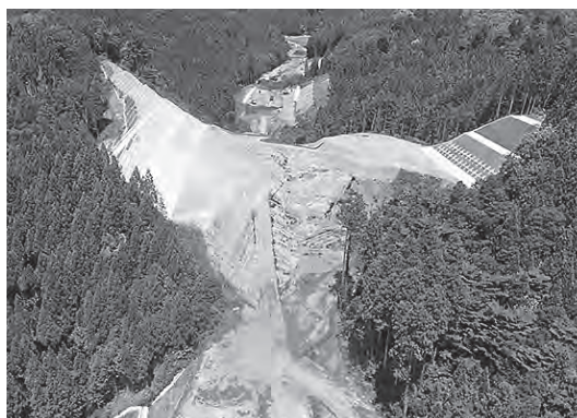
写真-3 2020年8月頃 本工事完成時
