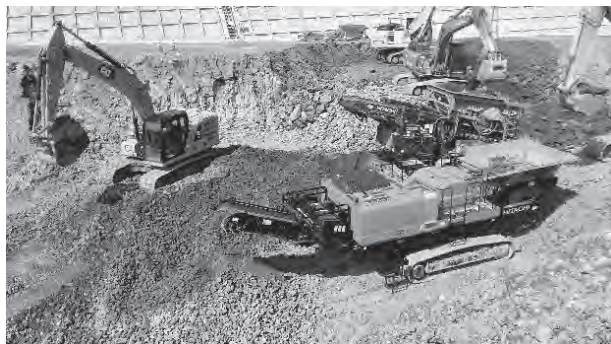
写真-6 ふるい分け (奥) ・小割破碎 (手前) 機械配置状況
