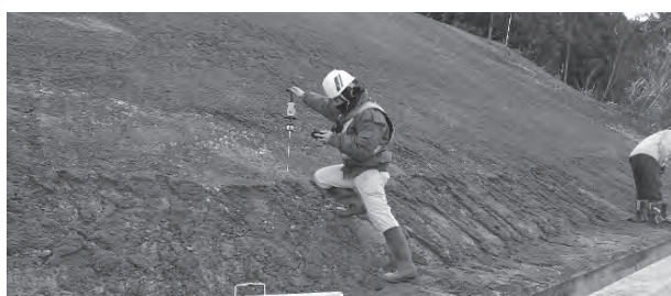
写真-8 法面整形時機械精度確認
