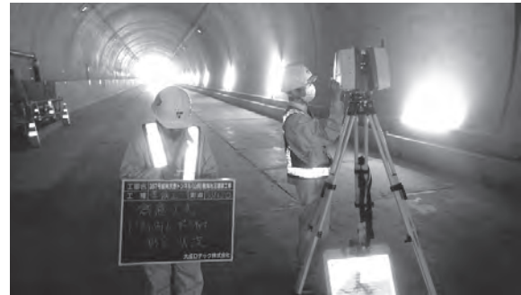
図-3 TLSによる計測状況
