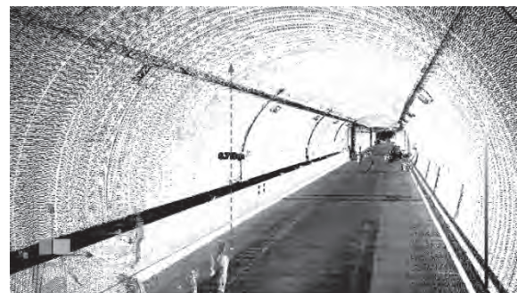
図-6 トンネル内部の高さ計測の一例
