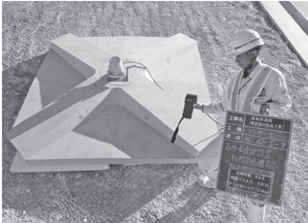
図-9 アンカー荷重計設置
