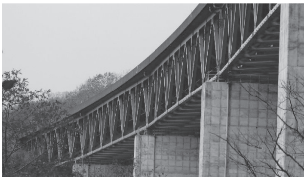
図-1 道央自動車道メップ川橋
