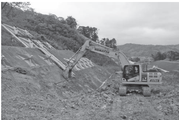
図-3 法面整形 (ICT建機)
