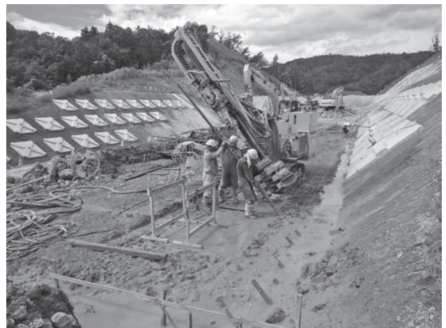
図-8 掘削用仮設対策工 (スリット鋼管)
