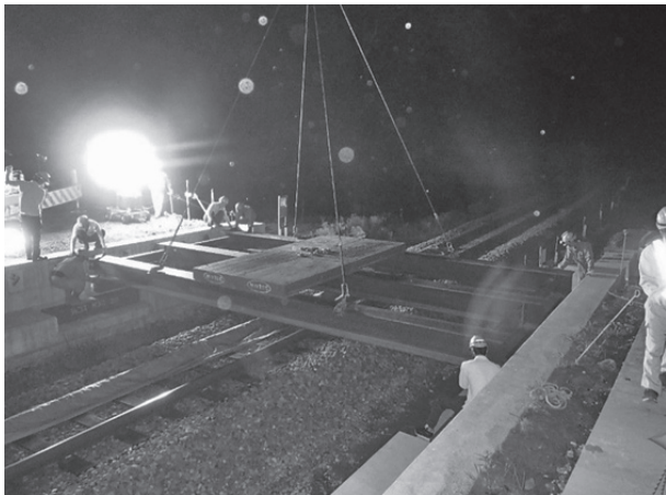
図-2 仮橋架設状況
