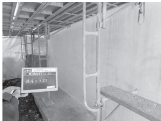
図-8 養生撤去完了時
