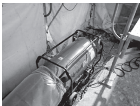
図-6 ジェットヒーター設置
