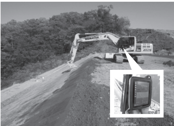
図-3 ICT建機による法面整形
