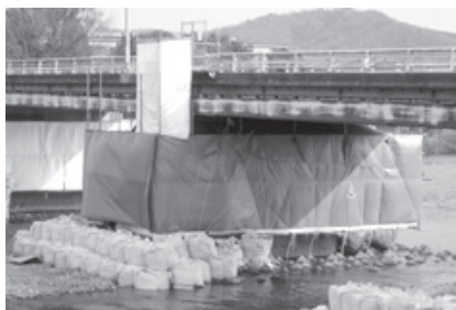
図-3 足場外部養生
