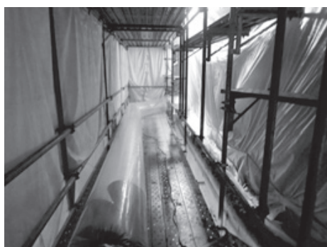
図-7 夜間の養生
