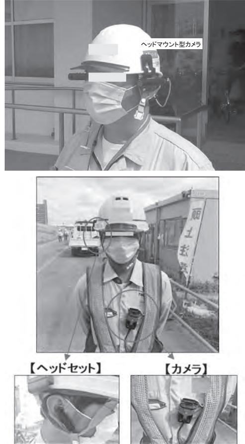
写真-2 カメラと音声による段階確認状況【工事現場】
