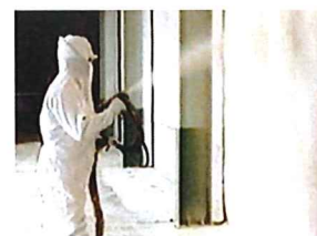
吹付ウレタン断熱工事
