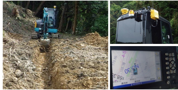
0.15m級バックホウのICT建機化
