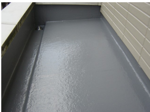
写真 1.2.1 FRP系塗膜防水の 施工の事例
