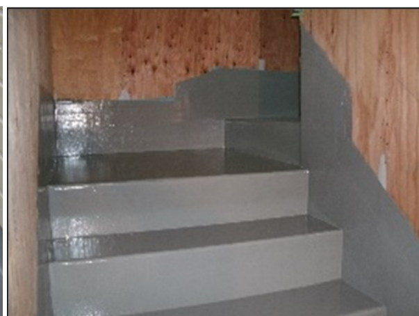
写真 1.2.2 屋外階段の 塗膜防水施工の事例
